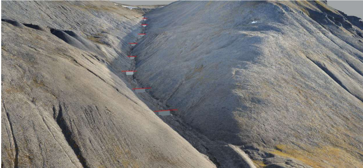
Figur 22: Nettkonstruksjoner oppover Vannledningsdalen
