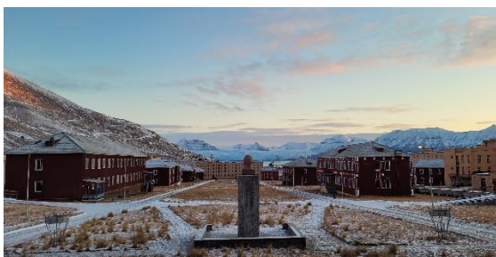
Pyramiden. Branntilsyn med Sysselmesteren, høst 2021.
