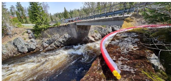
Strømkabelen klar for kryssing av Åsta.
