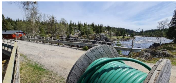
Strømkabelen klar for kryssing av Åsta.
