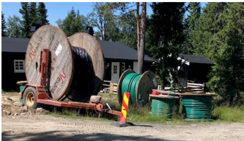
Kabelfremføring til hyttene!
