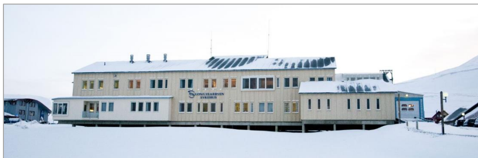
Figur 26: Longyearbyen sykehus (foto: Svalbardposten 2012)
