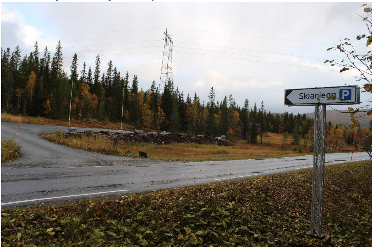
Figur 20 Avkjørsel til skianlegget med etablert parkering.
