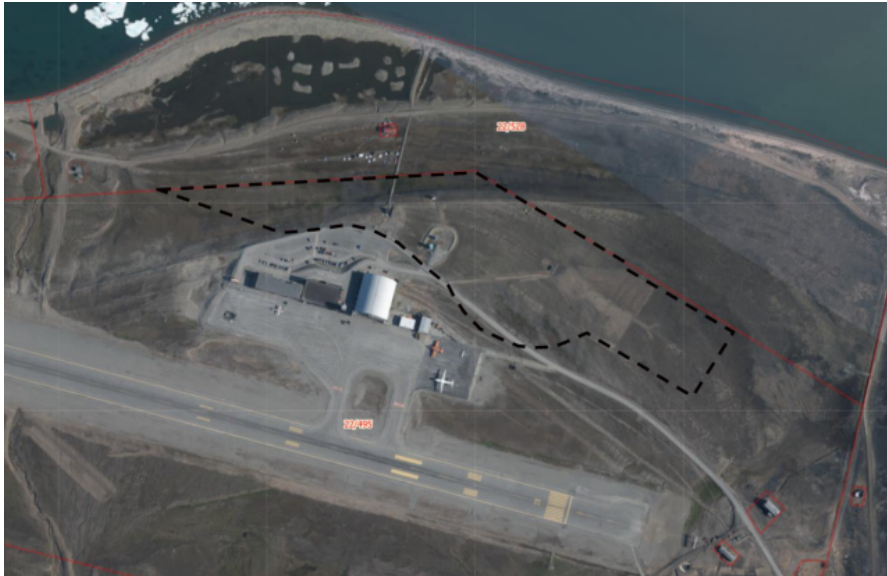
Figur 1 Ortofoto med plangrensa for planområdet i stipla linje. Etablering av LBG-energianlegg er tenkt plassert aust for den eksisterande blå tankgården.
