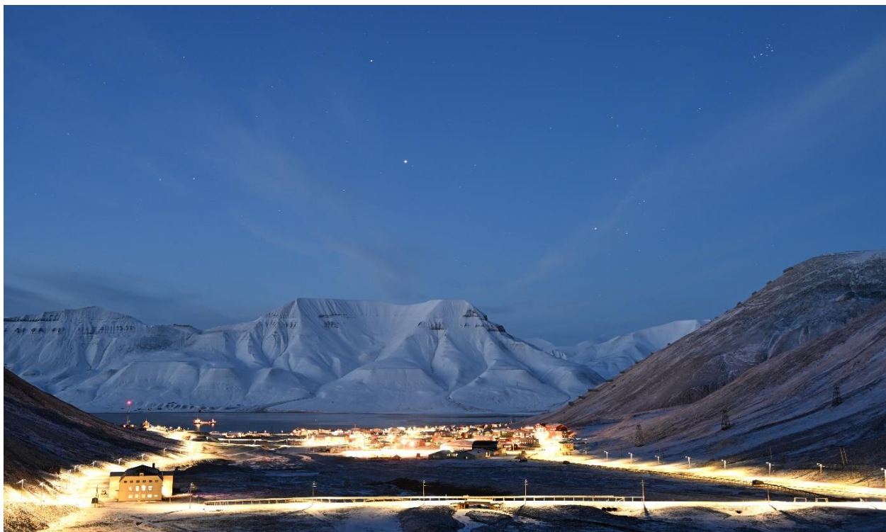
Bilde1 Det har blitt gjennomført et omfattende sikringsarbeid på Sukkertoppen for å sikre bebyggelsen mot skred og ras Foto: Bjørnar Kruse
